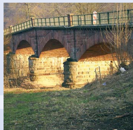
Seit über 100 Jahren verbindet die alte Sandsteinbrücke den Seulingswald mit Friedlos
