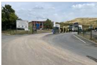
Zukünftig wird der Betrieb auf der Deponie in Friedlos vom AZV selbst durchgeführt. ...
