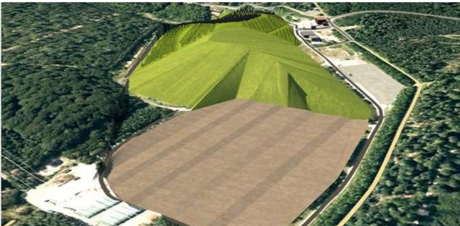
Die Deponie in Ludwigsau-Friedlos soll erweitert werden. Damit investiert der AZV in die Zukunft. - Grafik: Ingenieurgemeinschaft IG/IWB
