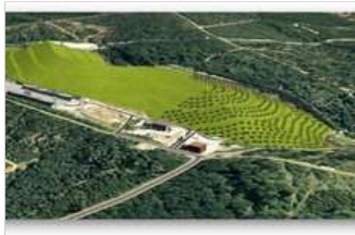
Auch eine moderne Fotovoltaikanlage soll auf dem Gelände entstehen.
