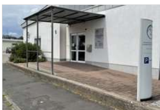
Die Zentrale in der "Kleinen Industriestraße" in Bad Hersfeld.
