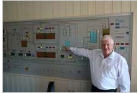
Stefan Katzmann vor der Kontrolltafel der Sickerwasserreinigungsanlage
